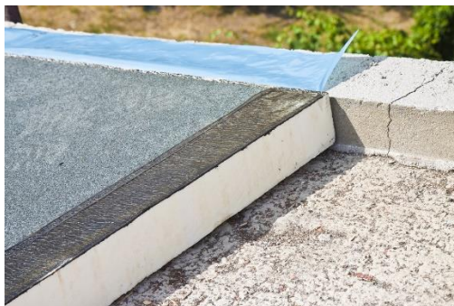
Figura 15. Acoperiș terasă - izolarea suprafeței exterioare 24
